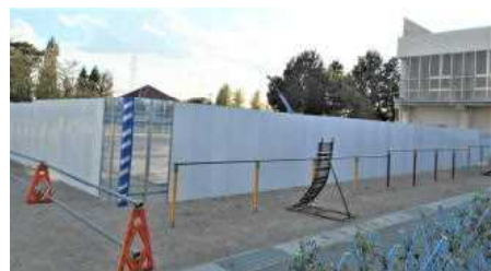
<校庭の工事用囲い>
