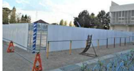
< As obras dentro do pátio >
